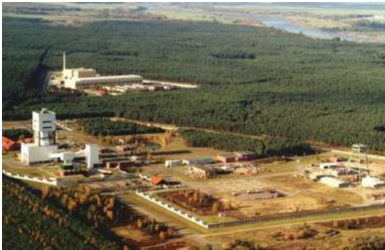
Rechts die Elbe, hinten die Zwischenlagerhalle mit Umpackanlage + Schornstein + Fasslager, vorne das große Gelände des „Erkundungsbergwerks“
