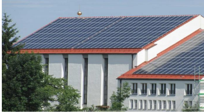
Kirche in Straßberg / Bobingen 2012 PV: 60 kW I B E
